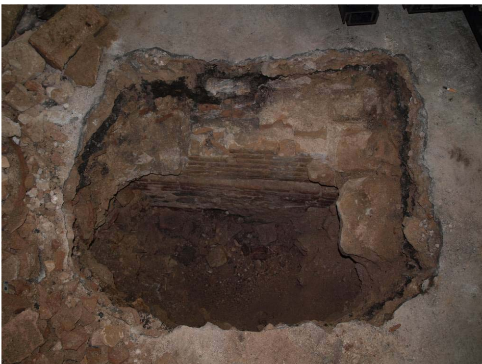
007_11_004: Cala 1: amb el nivell de rebliment UE 101 excavat i amb el mur Ue 102 visible.
