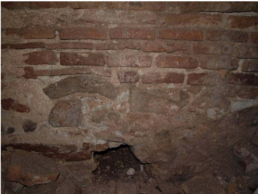
007_11_006: Cala 1: parament inferior del mur UE 102.
