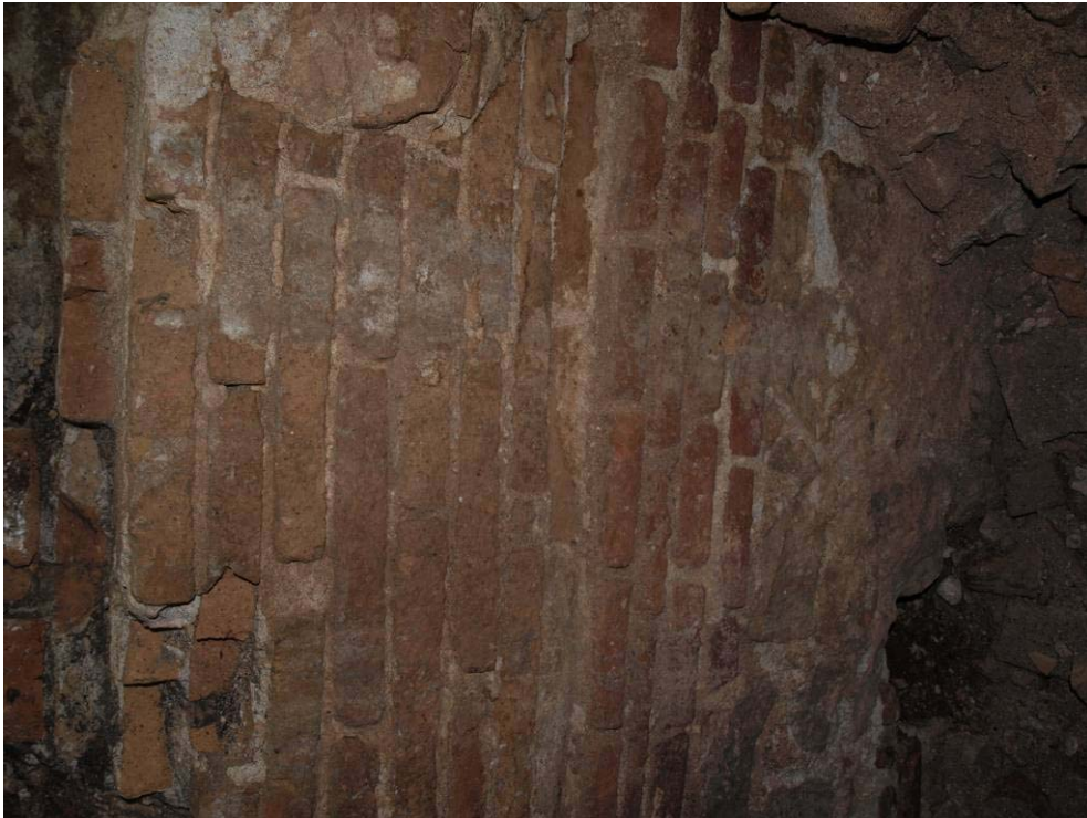
007_11_005: Cala 1: parament del mur UE 102.
